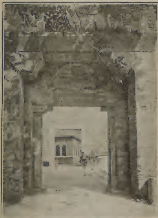
Fig. 21. Porte du mur terrestre : Yéni-Mévlévi-Hané-Kapou.
